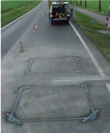
Carreteras provinciales, Holanda
